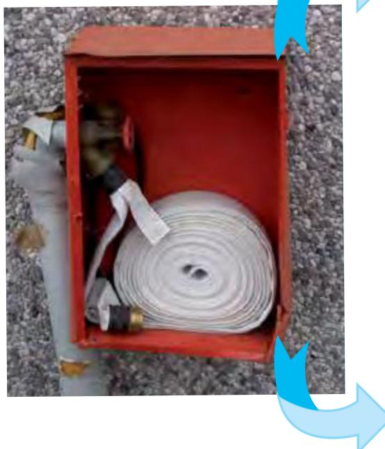
Togliendo le lamiere pretagliate sul lato e sul retro della cassetta la si può installare con la tubazione all'esterno della stessa senza dover smontare il rubinetto.
